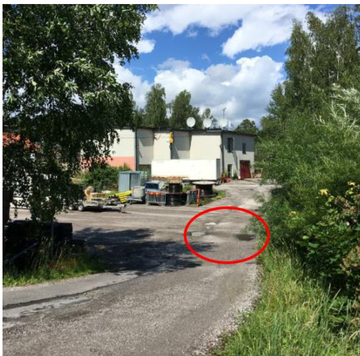
Figur 5. Bild över befintliga områdets lägsta punkt inringat i rött. Bild tagen från södra kanten av utredningsområdet (WSP 2019).
