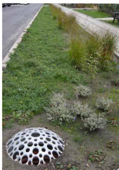
Figur 21. Nedsänkt växtbädd med kupolbrunn samt principskiss över växtbädd med fördröjningsvolym ovanpå bädden.
